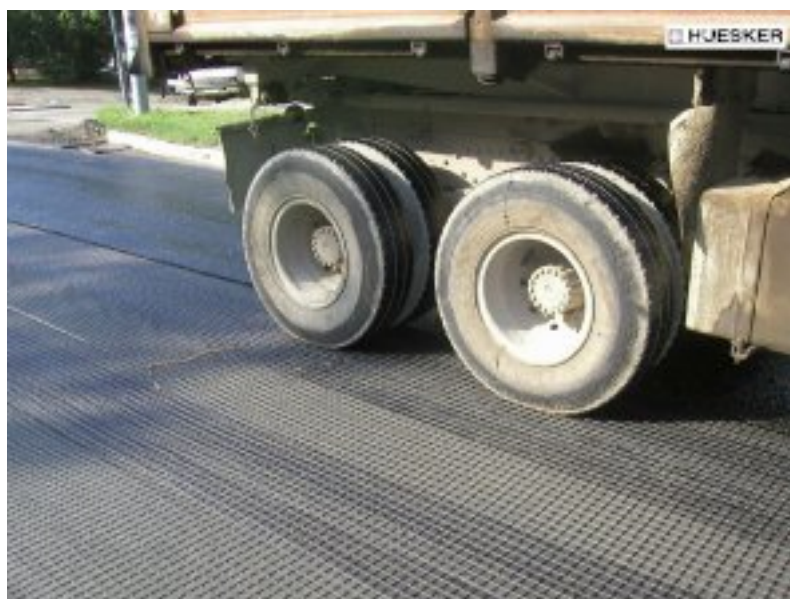
Obrázek 4 – Mřížka HaTelit C 40/17 pojížděna nákladním automobilem s asfaltovou směsí
