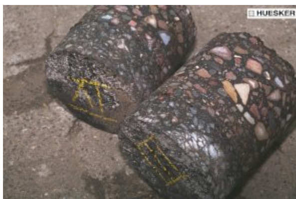
Obrázek 2 – Jádrové vývrty s výztuží
