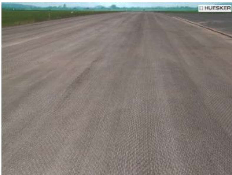
Obrázek 1 – Vyfrézovaná obrusná vrstva
