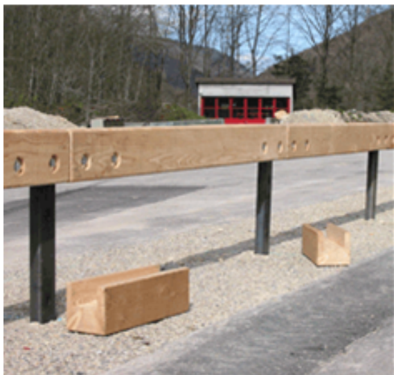
Obrázek 1 – Dřevěné svodidlo CH 2005, před montáží obložení sloupku a průřez svodidlem
