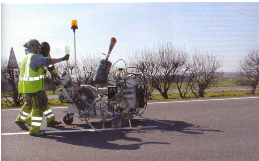
Foto 1 – Aplikace VDZ na zkušebním úseku v Clisson
