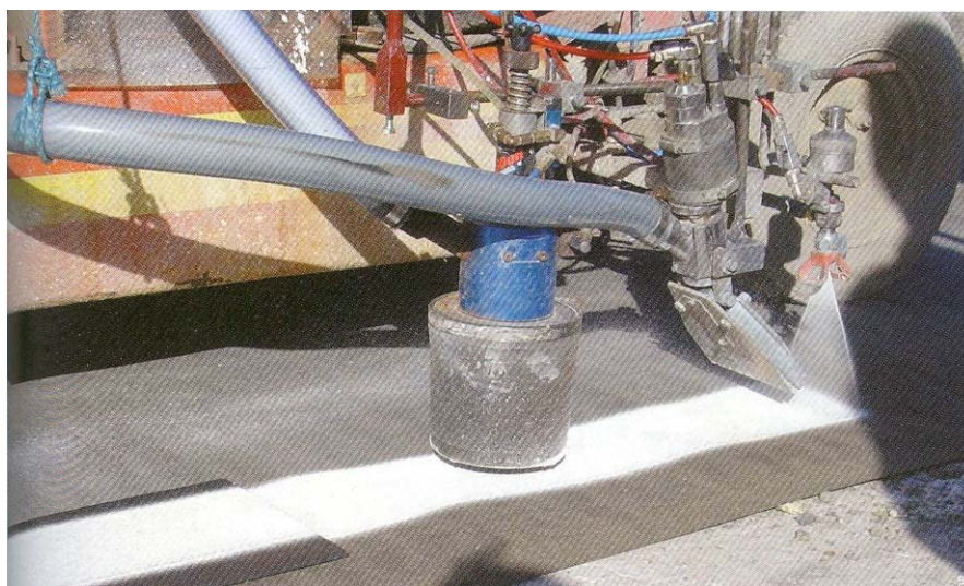
Foto 2 – Aplikace VDZ na zkušebním úseku v Cergy
