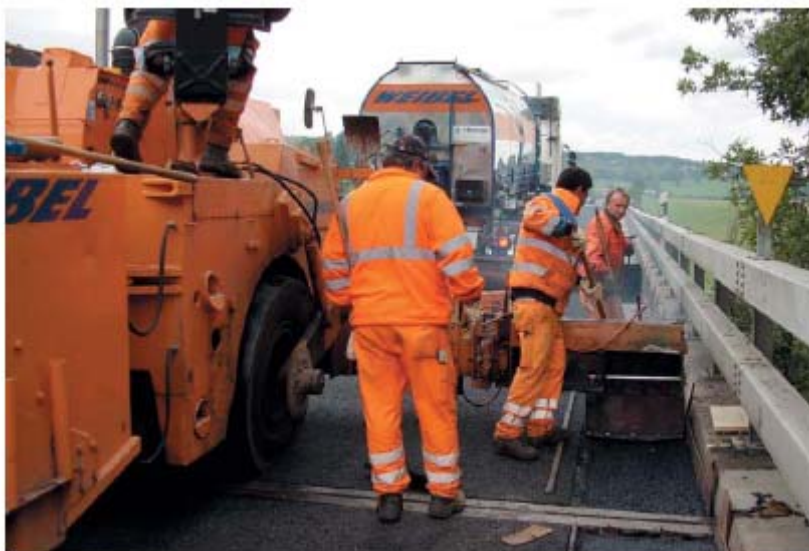
Obrázek 3 – Boční finišer, lišta s formou na žlábků
