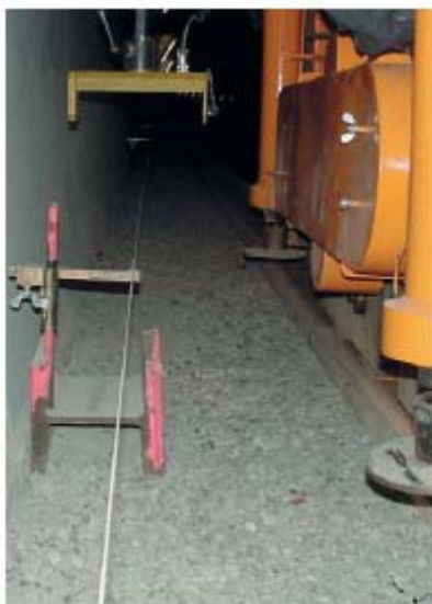
Obrázek 1 – Pokládka litého asfaltu podle vodícího drátu pomocí finišeru EB 100 S Linnhoff
