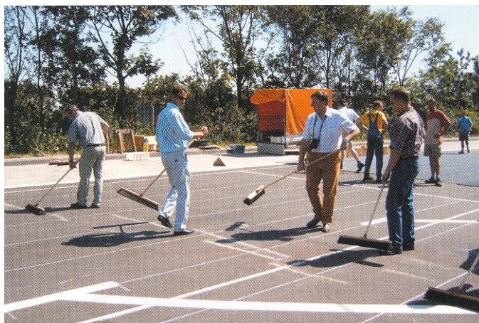
Obrázek 5 – Mechanické odstraňování (zametání) posypového materiálu
